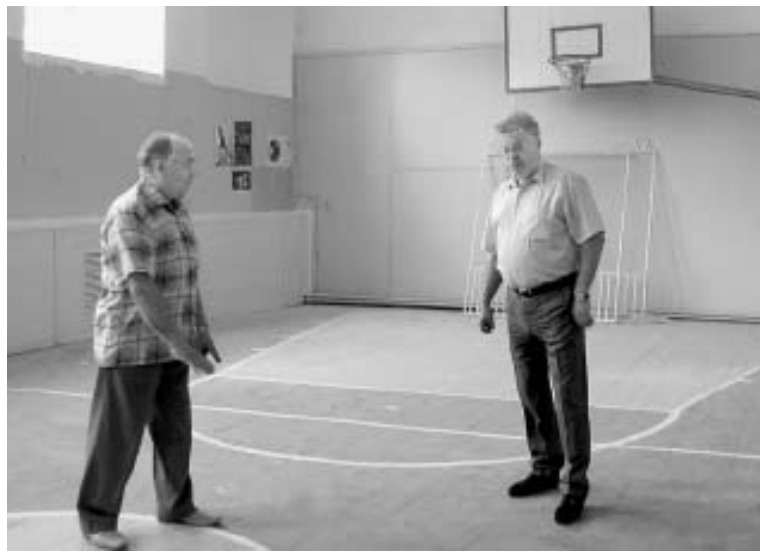
Вячеслав Павлович в интернате № 12 контролирует процесс ремонта спортзала.
